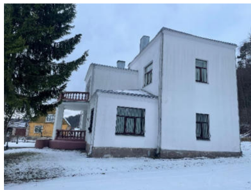
2.attēls. Administratīvā ēka
