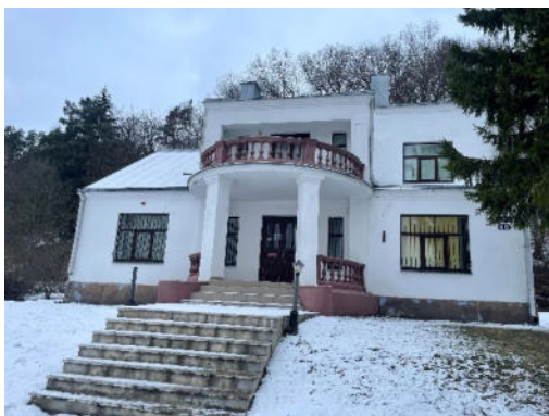
1.attēls. Administratīvā ēka
