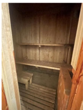
23.attēls. Somu pirts (1.stāva telpa Nr.8)
