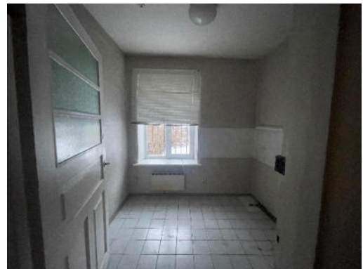
14.attēls. Palīgtelpa (1.stāva telpa Nr.3)
