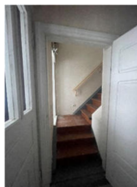
24.attēls. Kāpņu telpa (1.stāva telpa Nr.10)
