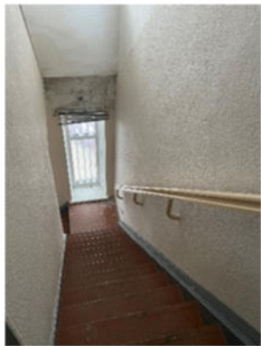
25.attēls. Kāpņu telpa (1.stāva telpa Nr.10)
