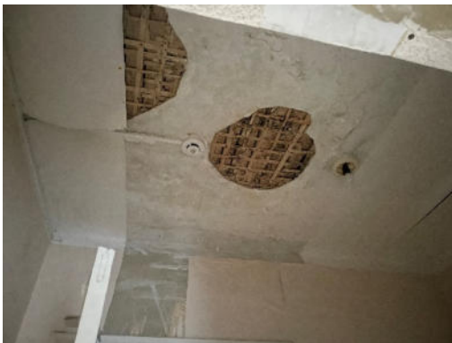
13.attēls. Gaitenis (1.stāva telpa Nr.6)
