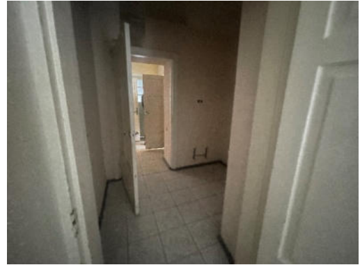
12.attēls. Gaitenis (1.stāva telpa Nr.6)
