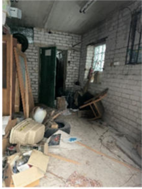
41.attēls. Palīgtelpa (telpa Nr.4)
