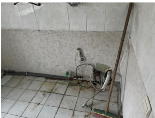
15.attēls. Palīgtelpa (1.stāva telpa Nr.3)
