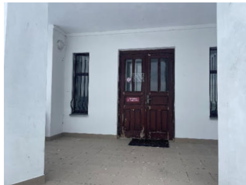
36.attēls. Ārtelpa (1.stāva telpa Nr.14)
