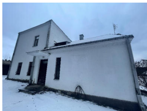
4.attēls. Administratīvā ēka
