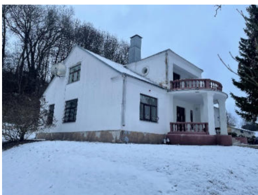
3.attēls. Administratīvā ēka
